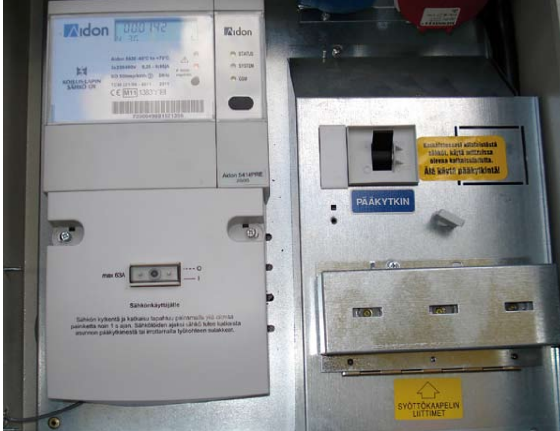
Uusi mittari on asennettu paikalleen.
