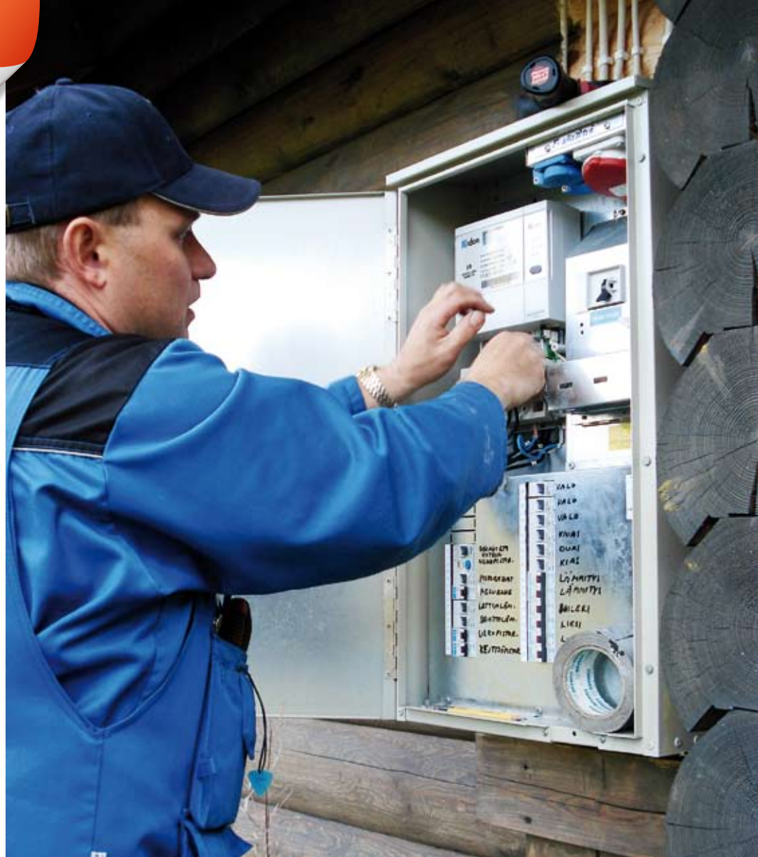
Asentaja Risto Moilanen Ellappi Oy:stä vaihtaa mittarit Koillis-Lapin Sähkö Oy:n toimialueella. Syys-kuun alkupuolella oli vaihdettu noin 1.300 mittaria.
