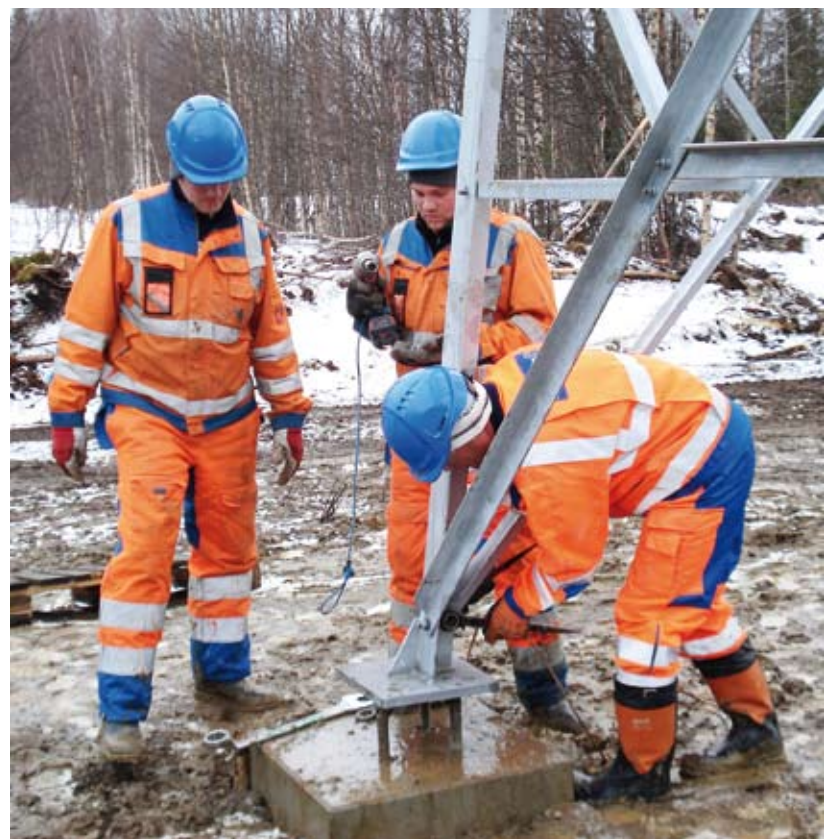
Nosto meni nappiin. Nosturit kannattelevat 47,5 metriä korkea pylvästä siihen asti kunnes se kiinnitetään betonianturaan.
