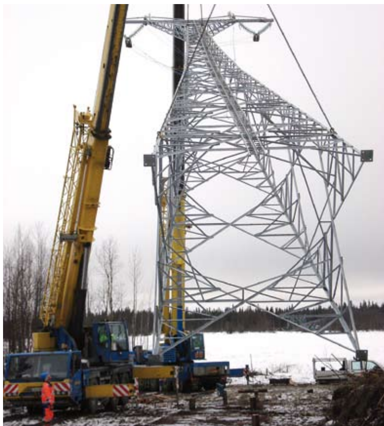
Valmistelutyöt on tehty. Pylväs kohoaa hitaasti ja varmasti irti maasta.
